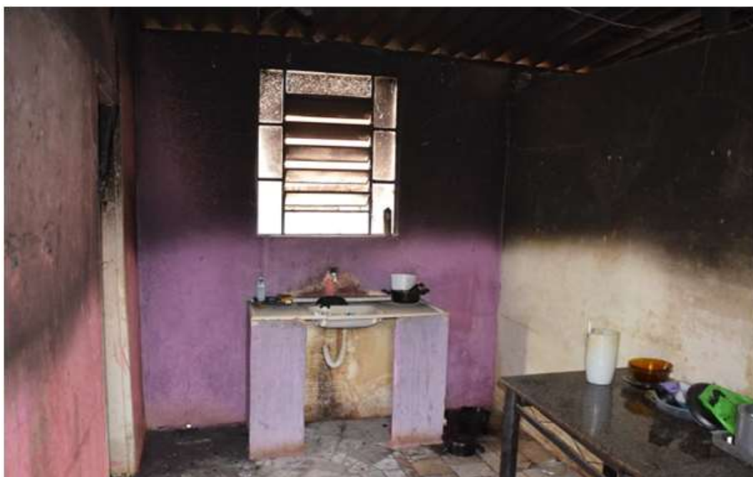
Figura 5. Cômado não atingido diretamente pelas chamas do incêndio, houve apenas depósito de fuligem, que veio pela porção superior do recinto ( Fonte: Arquivo pessoal dos autores ).
